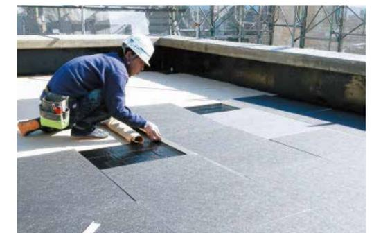
モイスポット張付け後、断熱材T張付け
